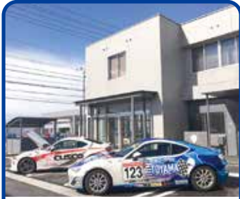
GR Garage富山新庄 車両展示
